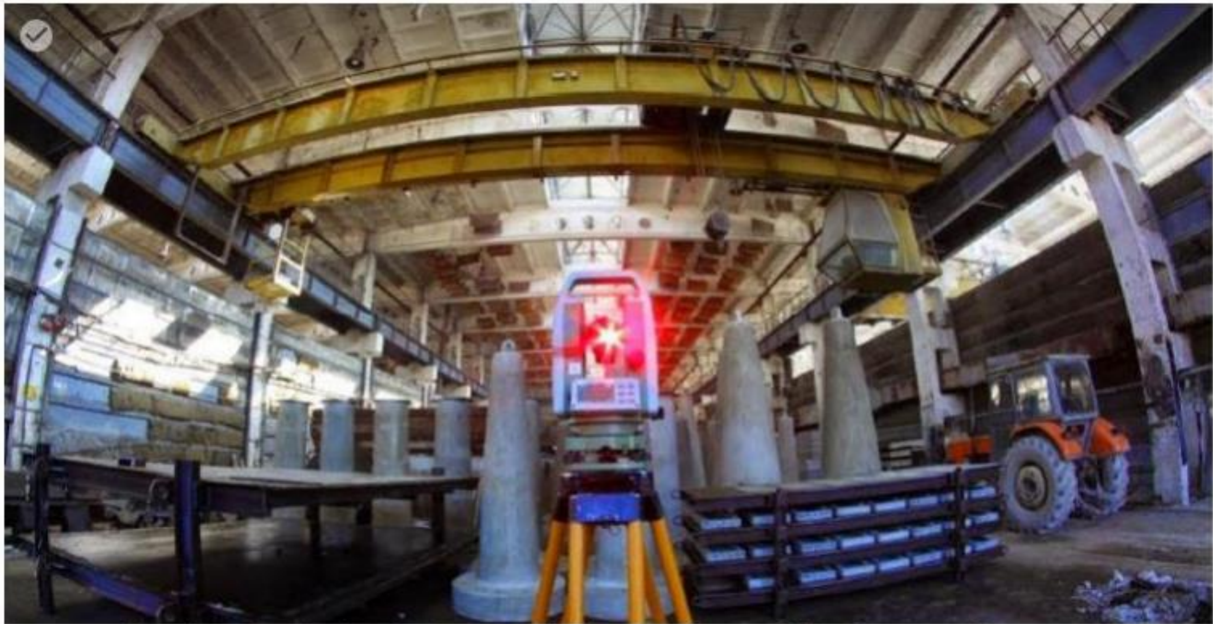
Pomiary kontrolne betonowych elementów prefabrykowanych.
